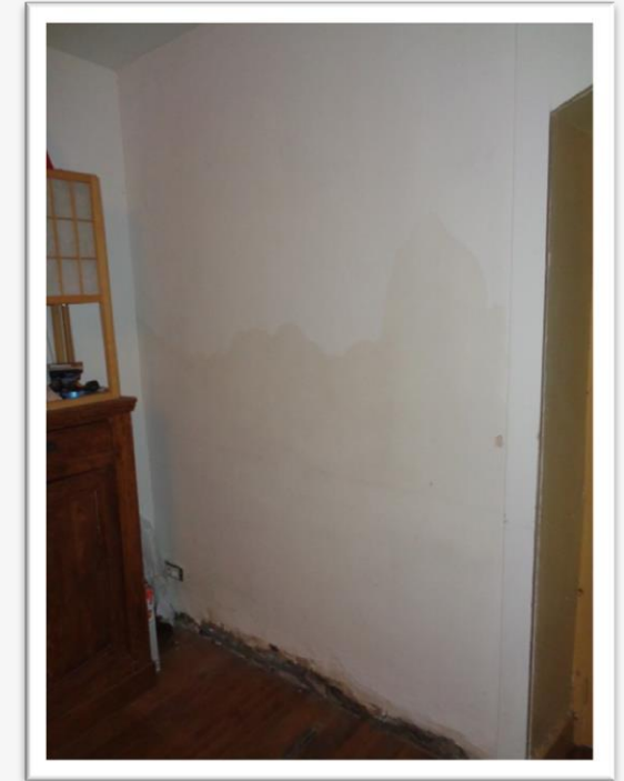
Remontées capillaires, Source Ajena
