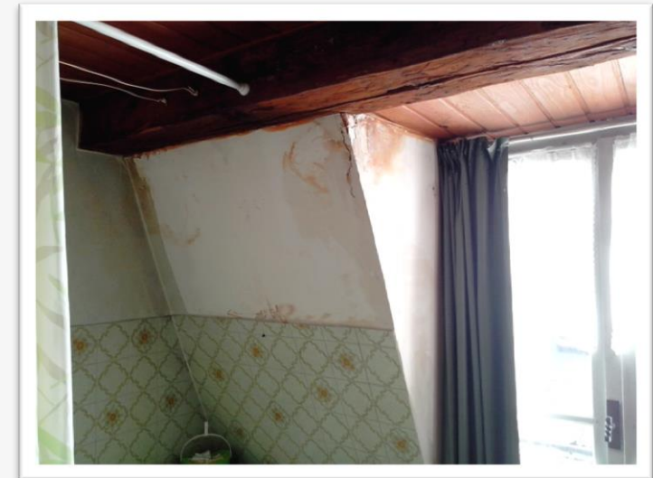
Infiltrations dues à une zinguerie défectueuse, Source Ajena
