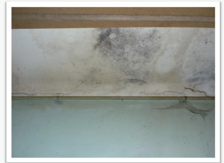
Moisissures, Source Ajena
