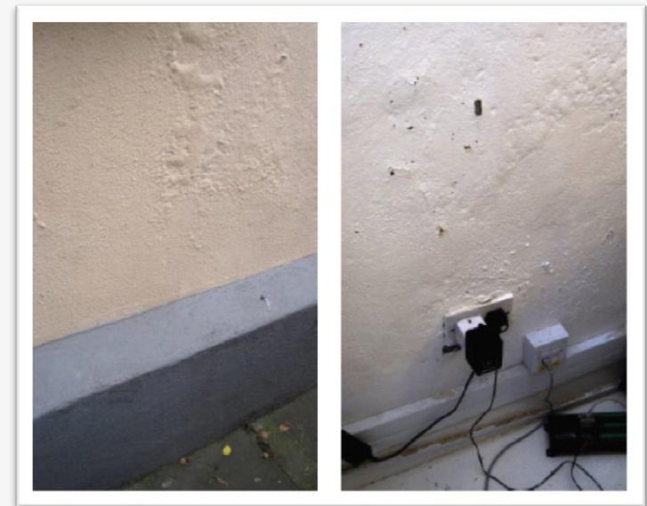
Remontées capillaires : dégradation des parements, Source J. Little
