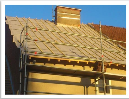
Pose d'un écran de sous-toiture, Source Ajena
