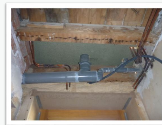
Passage de réseaux sous plancher - Source Ajena
