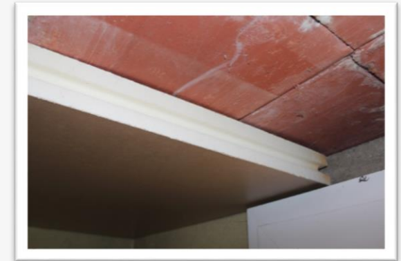
Isolation en sous face limitée par l'espace disponible au-dessus des portes - Source Effilogis
