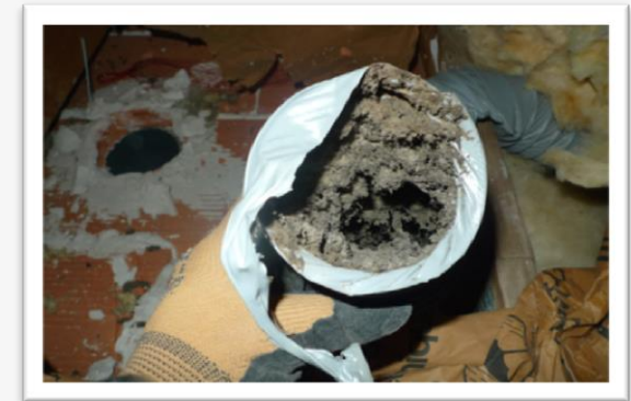
Gaine souple encrassée, Source www.ei-tricot.fr
