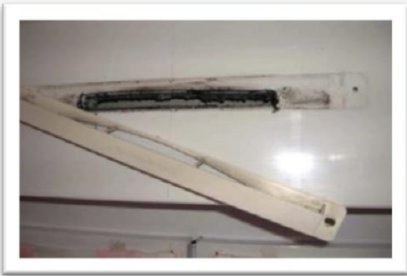
Entrée d'air encrassée, Source www.groupe-sma.fr
