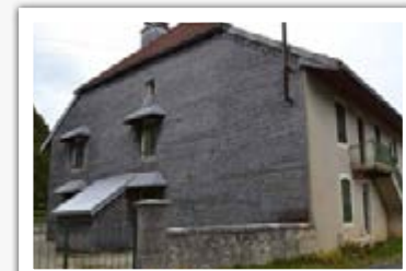
Bardage tavaillon, Fort-du-Plasne, 39 Source CAUE39
