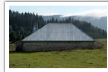
Chalet d'alpage, toiture à 4 pans, Lajoux, 39 Source CAUE39
