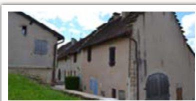
Maison à "pas de moineaux", Maynal, 39 Source CAUE39
