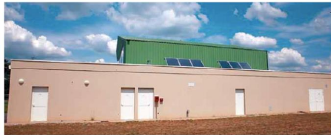
Complexe sportif à Escource, (chauffage et eau chaude solaire, avec ventilo convection
