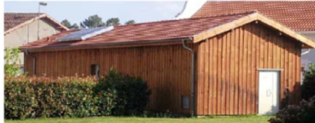
Toilettes publiques «autonomes» à Escource, avec
