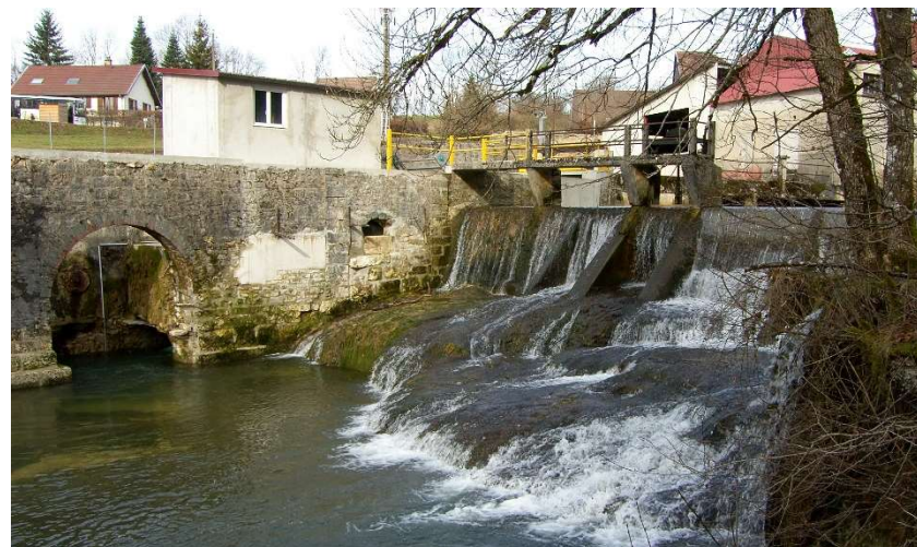
Centrale hydroélectrique de Ardon, sur l'Angillon (39300).
