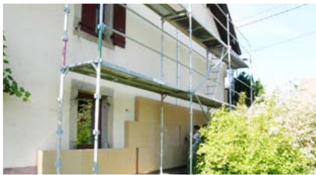
Isolation par l'extérieur en fibre de bois - Source Effilogis
