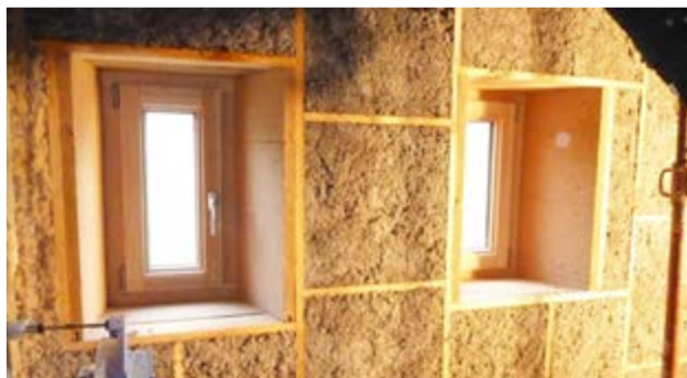
Isolation par l'intérieur ouate de cellulose - Source Ajena
