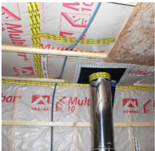
Traitement de l'étanchéité à l'air - Source Ajena
