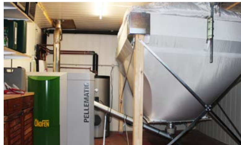
Chaudière à granulés de bois et silo d'approvisionnement - Source Effilogis
