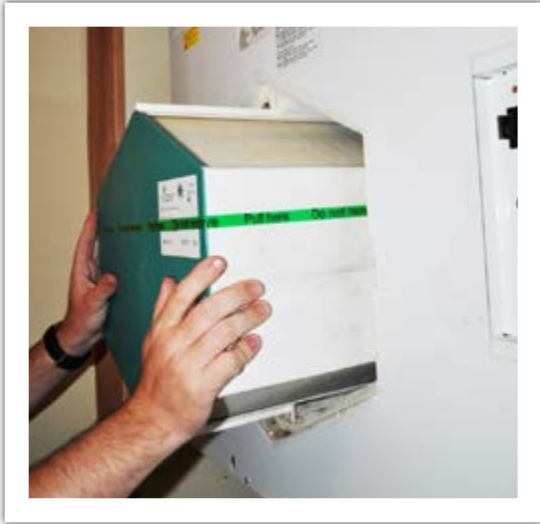
Changement du filtre d'une VMC double flux - Source Ajena
