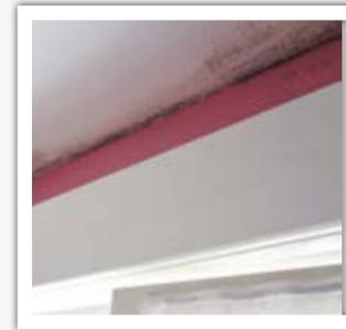
Menuiseries sans entrées d'air, ponts thermiques = moisissures - Source Ajena
