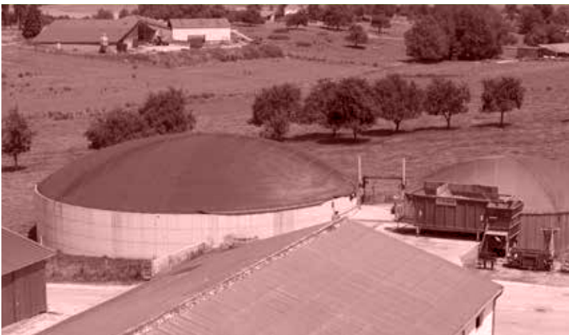
Production de biogaz ©David Cesbron
