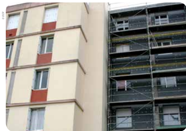
▷ Travaux de pose de l'isolation par l'extérieur
