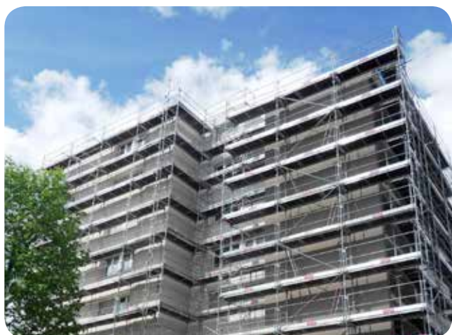
▷ La copropriété Le Durgeon à Vesoul au cours des travaux
