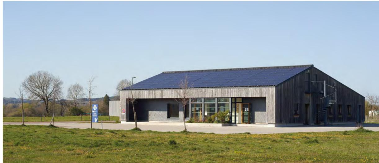
Les maîtres d'ouvrages souhaitent construire un bâtiment confortable, avec des coûts de fonctionnement réduits et une faible empreinte écologique. L'idée était de proposer un projet de construction à ossature bois, isolée en bottes de paille, des murs jusqu'à la toiture et au plancher sur vide sanitaire. La paille, comme matériau local, peu cher, avec un coût environnemental extrêmement faible, correspondait bien aux exigences de performances énergétiques et au respect de l'environnement.
