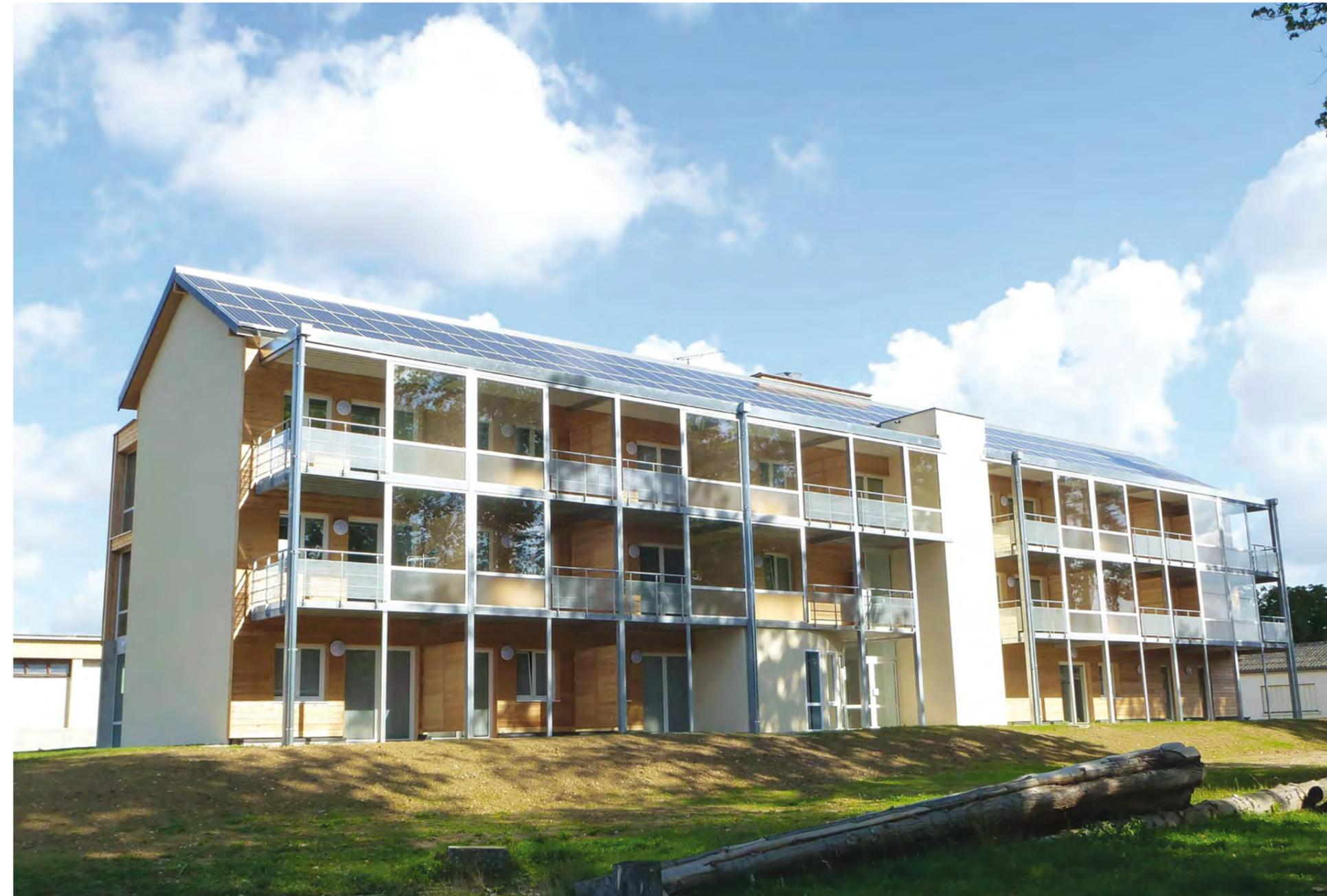
de la lumière et de la chaleur. Les logements sont équipés d'une ventilation VMC double-flux avec, en cas de nécessité, un appoint individuel électrique (panneaux rayonnants). L'eau chaude sanitaire est produite par 4 ballons de type thermodynamique. Des panneaux photovoltaïques permettent de générer de l'électricité ensuite revendue à EDF.
